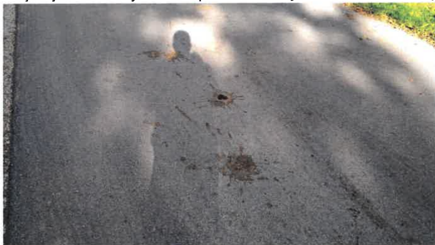
Rysunek 11 - Odpady poprodukcyjne na drodze gminnej w bliskim sąsiedztwie fermy, źródło: wizja lokalna na nieruchomości z dnia 10.09.2020 r.
